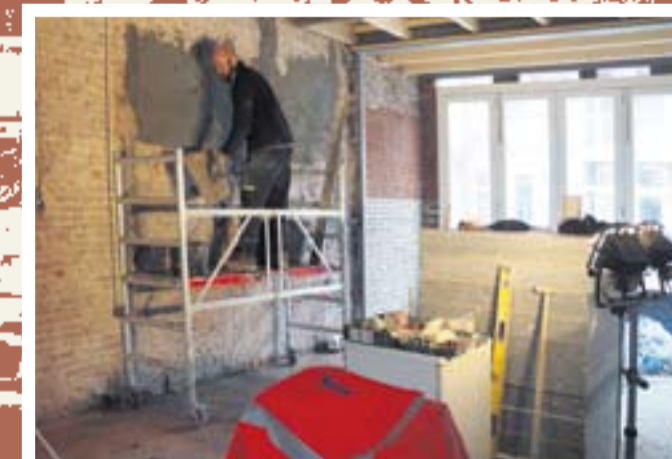
Thijs Klomp aan het metselen in de Bloklandstraat
